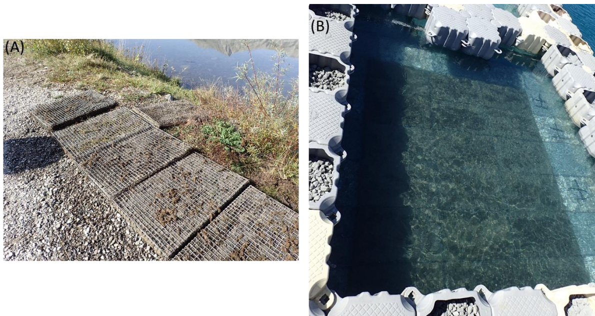
Figure 14 : Photographies de la réalisation et de l'installation des cages végétalisées à végétation gazonnante. (A) Cages grillagées végétalisées prêtes à être installées ; (B) Mise en place des 18 cages végétalisées dans un étage à -0.5m d'une FLOLIZ. ©Projet UROS
