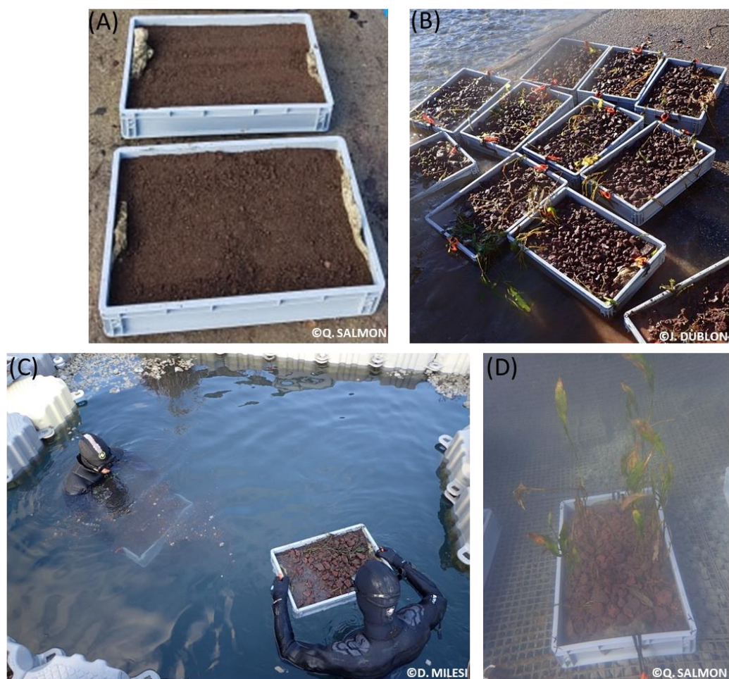
Figure 16 : Photographies de l'étape de végétalisation des FLOLIZs par les Potamogetons. (A) Bacs remplis de terreau aquatique avant plantation ; (B) Bacs végétalisés et recouverts de pouzzolane ; (C) Fixation des bacs à la structure des FLOLIZs ; (D) Illustration d'un bac installé dans une FLOLIZ. ©Projet UROS
