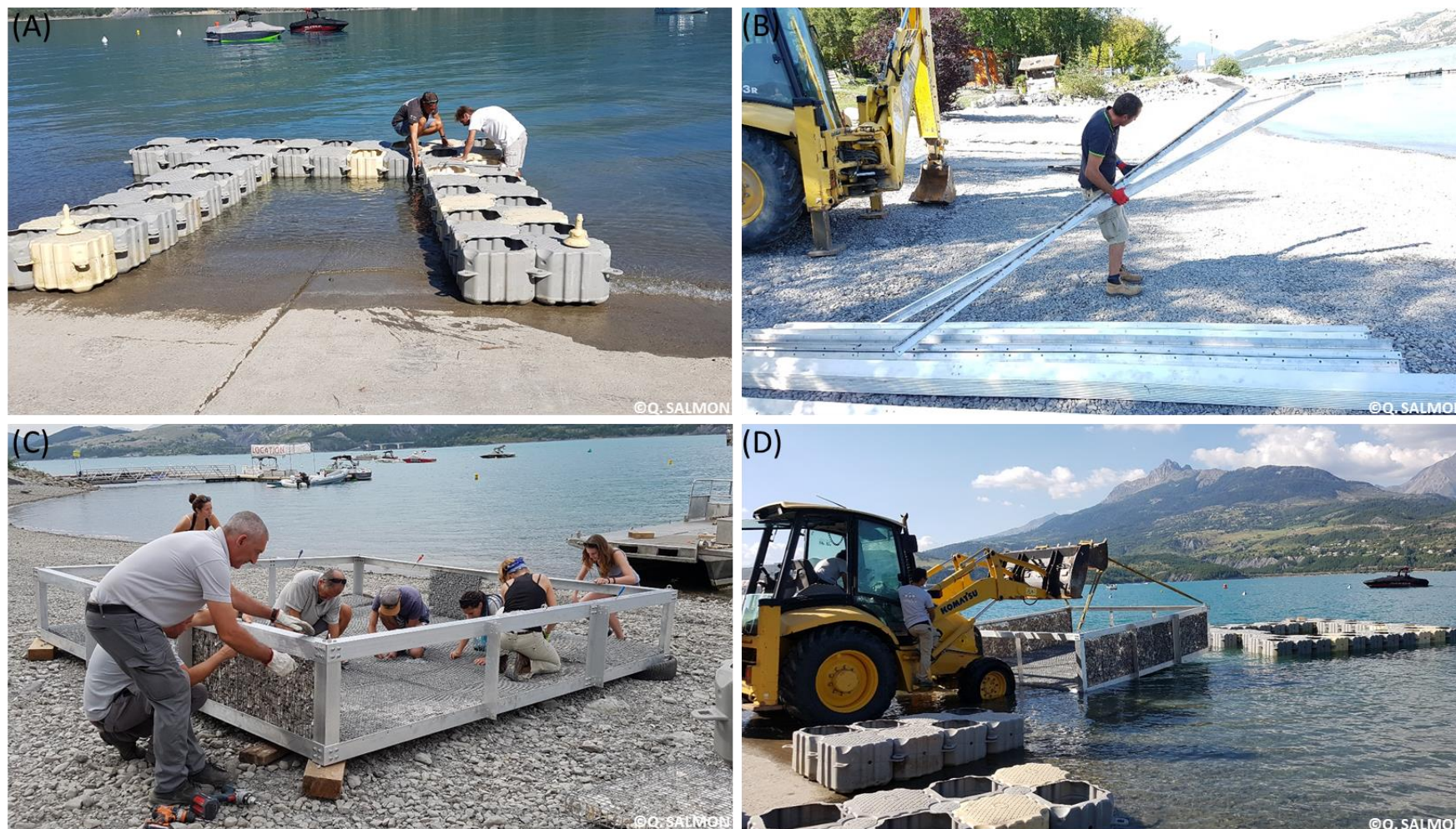
Figure 8 : Photographies des différentes étapes de l'assemblage des FLOLIZs. (A) Assemblage des caissons flottants MarineFloor® (partie émergée); (B) Assemblage des barres en aluminium pour constituer le squelette (partie immergée); (C) Fixage des cages grillagées contenant les substrats minéraux sur le fond et les côtés latéraux du squelette en aluminium; (D) Mise à l'eau des squelettes en aluminium pour assemblage avec la partie flottante. ©Projet UROS
