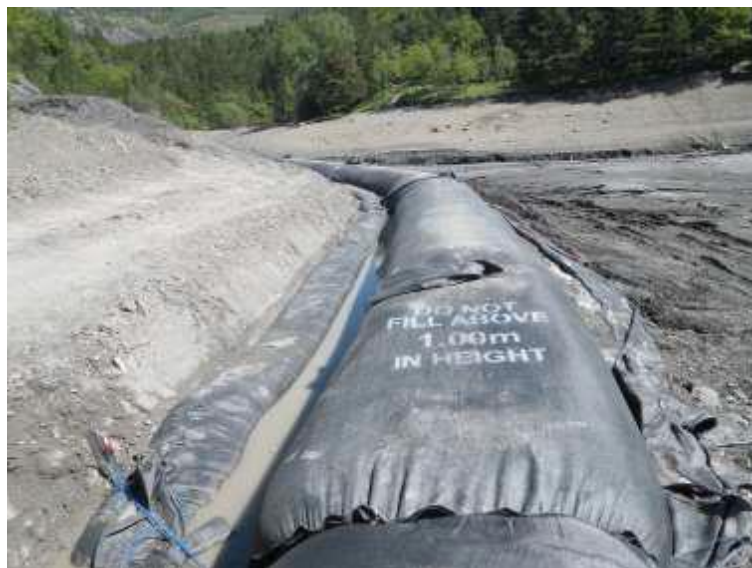
Figure 7 : Photographie de la pose d'un Géotube® sur la zone de terrassement. ©SMADESEP
